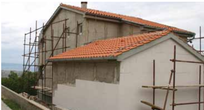
Izolacija obiteljske kuće s vanjske strane zida, Rijeka
