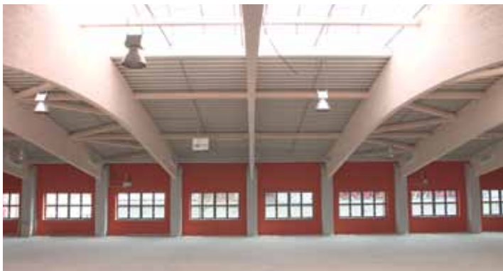
Izolacija stropa, dvorana Fulda
