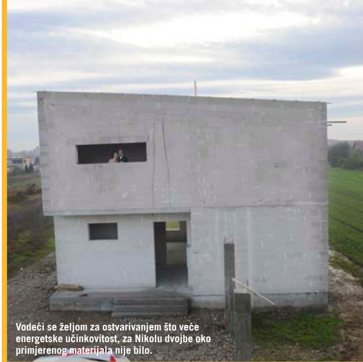
Ytong kuće obitelji Pavlović i Biškić doslovce su niknule kroz pedesetak efektivnih dana izgradnje s građevinskim timom od svega pet radnika.
