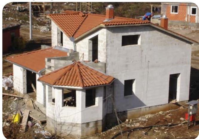
Primjer izvedbe Ytong krovnih konstrukcija
