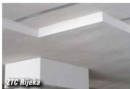
ZTC Rijeka – Multipor kao dodatna toplinska izolacija stropova
