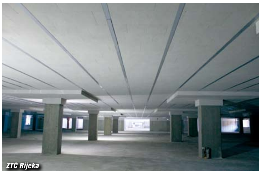
ZTC Rijeka – Multipor kao dodatna toplinska izolacija stropova
